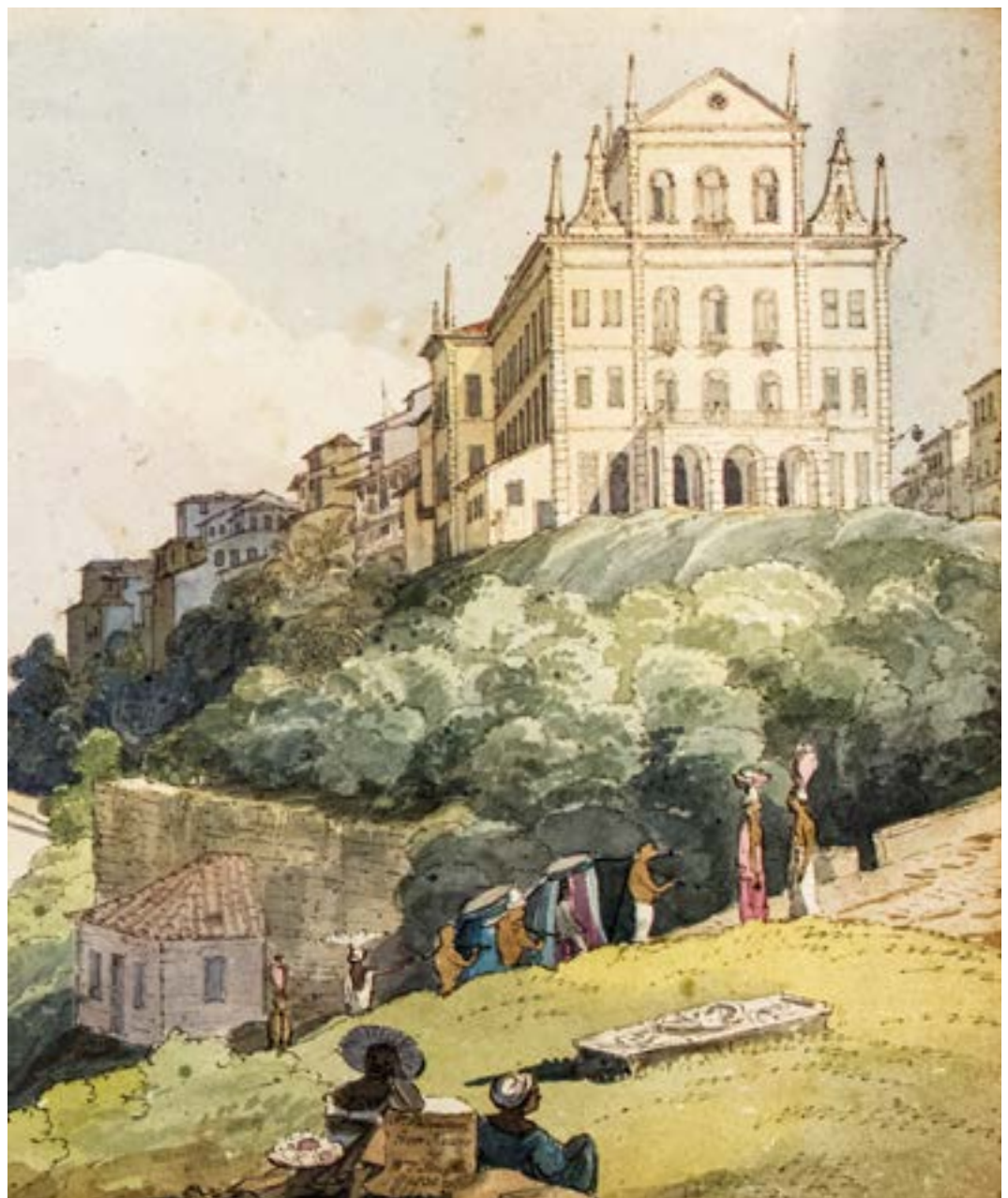
Detalhe – Teatro São João
